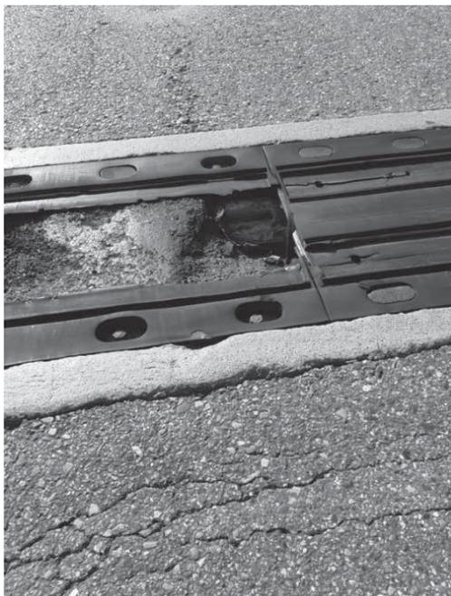
Figura 5 – tipologia di degrado giunti S.P. 13 Km 4+480
