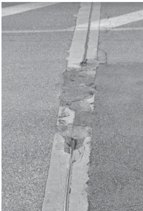
Figura 3- tipologia di degrado giunti S.P. 13 Km 4+316
