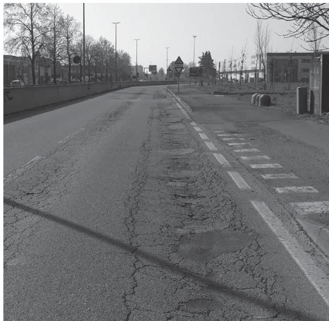
Figura 2- tipologia di ammaloramenti della pavimentazione stradale per cui intervenire
