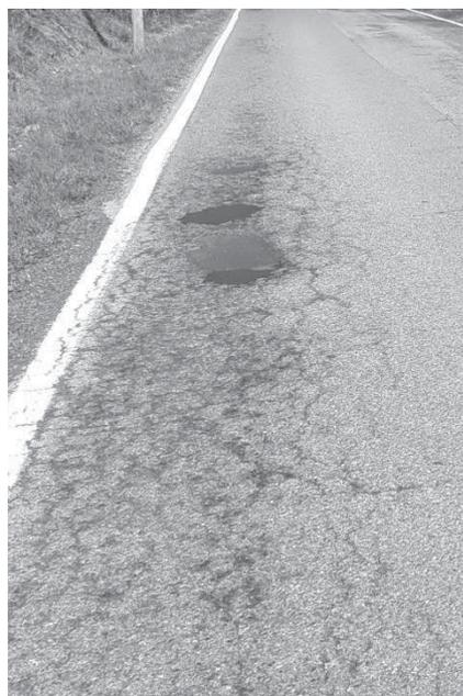
Figura 1- tipologia di ammaloramenti della pavimentazione stradale per cui intervenire
