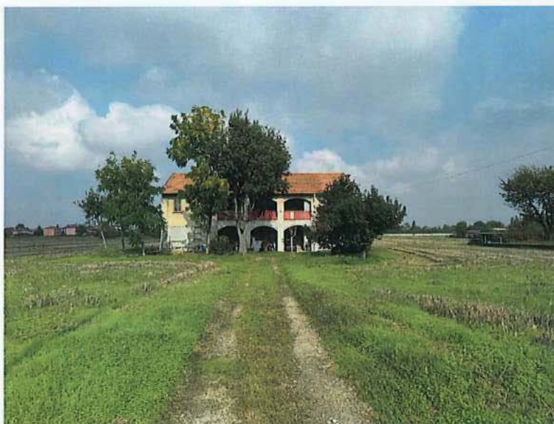
Via della Novella - Esempio di edificio rurale storico ben inserito nel contesto paesaggistico esistente.
