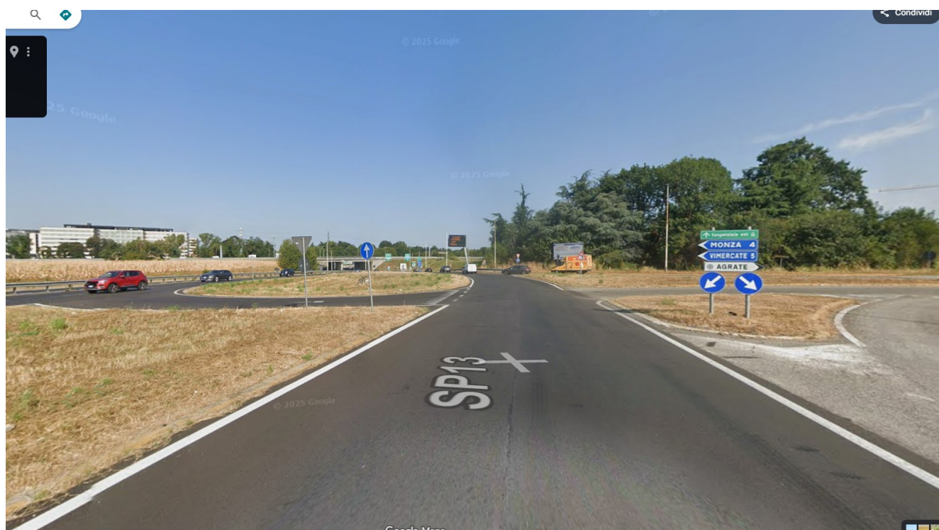
Fotografia direzione Monza incrocio SP 13 - km. 3+730 – Via Matteotti di Agrate B.
