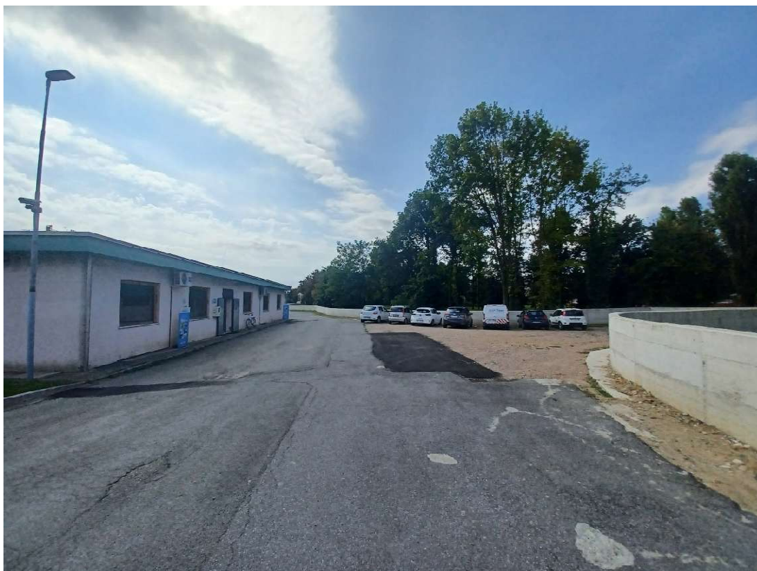
Fotografia 15 – Muro di protezione idraulica e uffici depuratore – Data 23.07.2025
