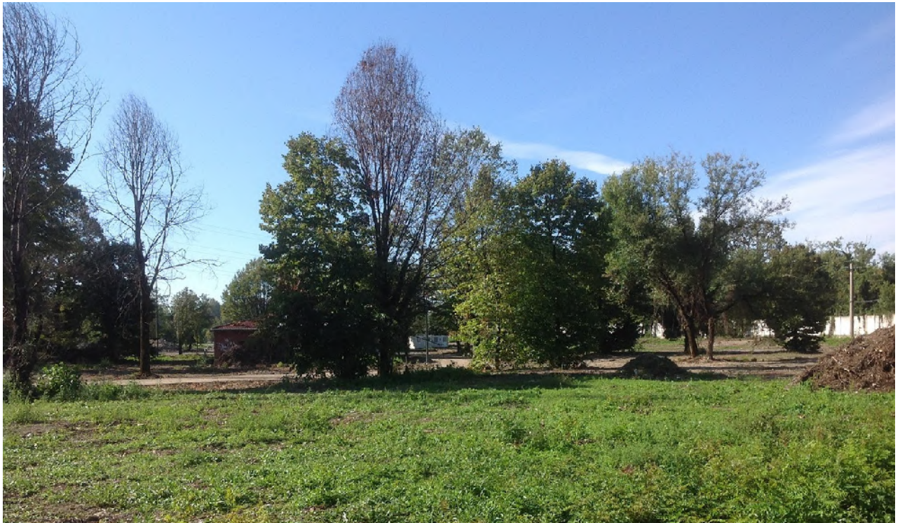
Figura 11: Area ex campo nomadi: lavori di riqualificazione in corso (data: 2021)
