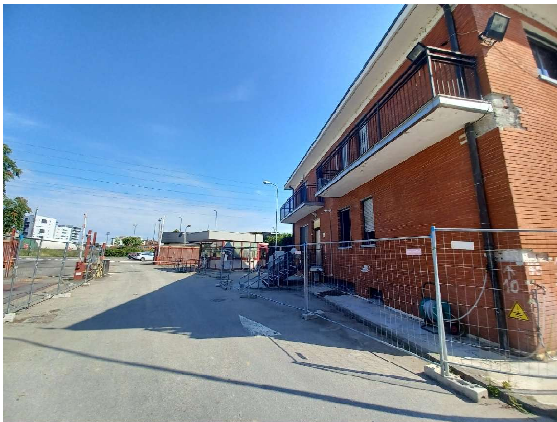
Fotografia 4 – Ingresso palazzina laboratori/uffici – Data 23.07.2025
