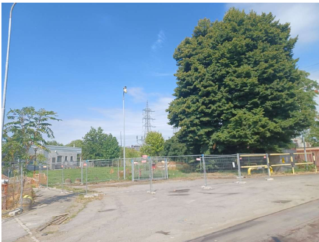
Fotografia 9 – Piazzale di manovra – Data 23.07.2025
