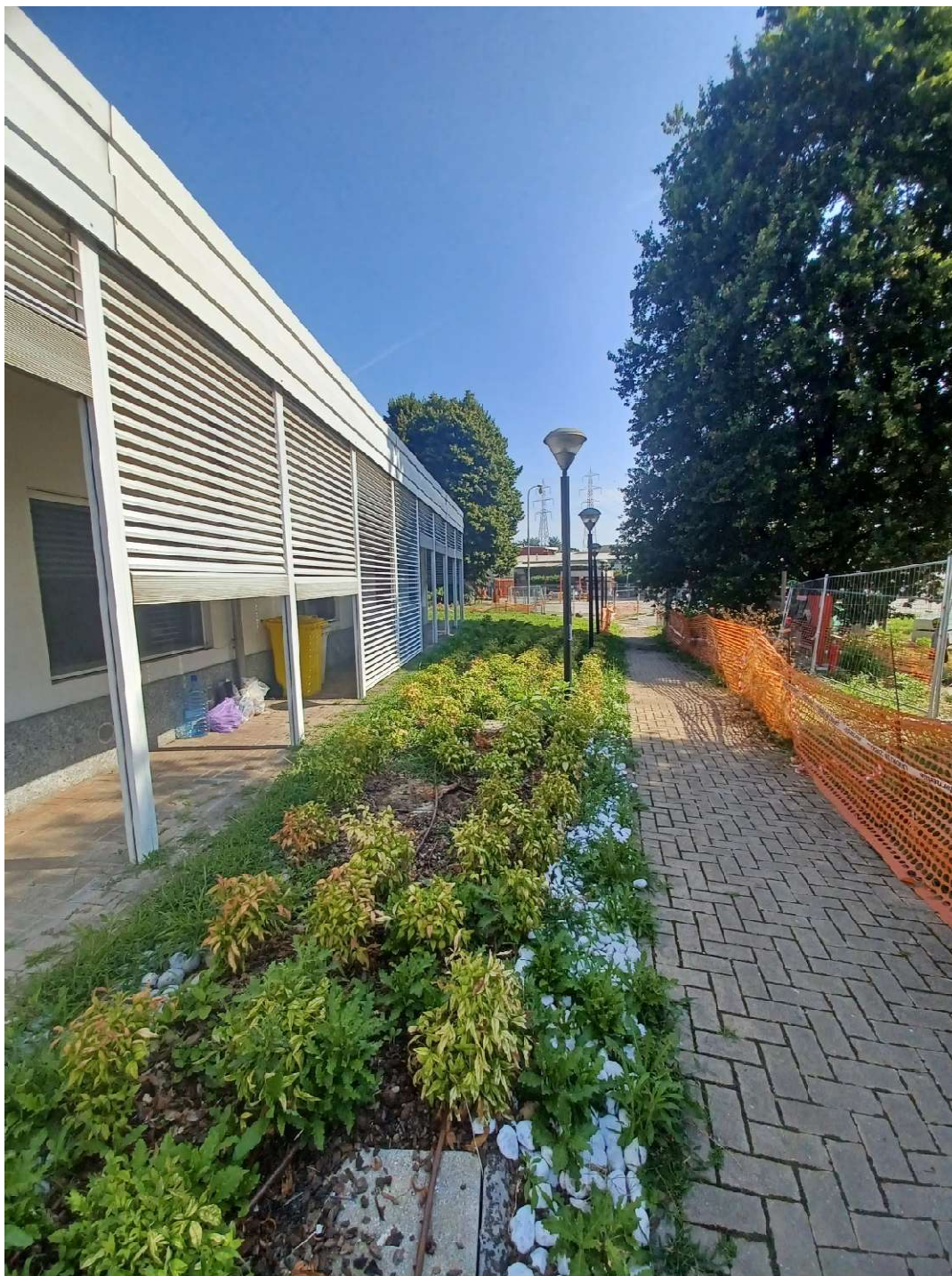
Fotografia 1 – Fronte Sud Est Uffici – Data 23.07.2025
