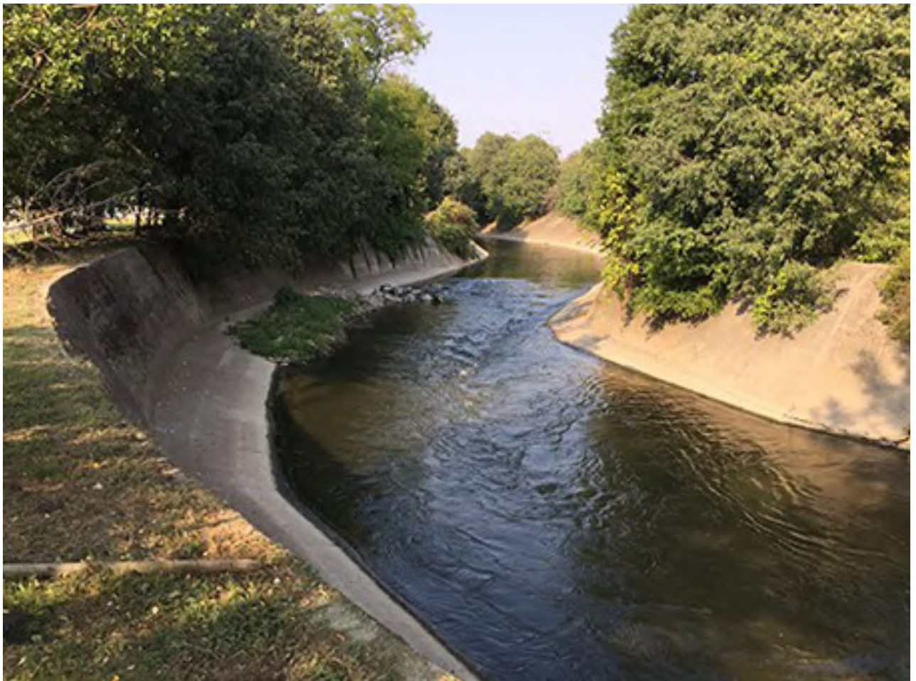
Figura 6: Il tratto del Lambro nel tratto prossimo agli impianti: il corso è stato rettificato e le sponde sono trattate come un canale (data: 2021)
