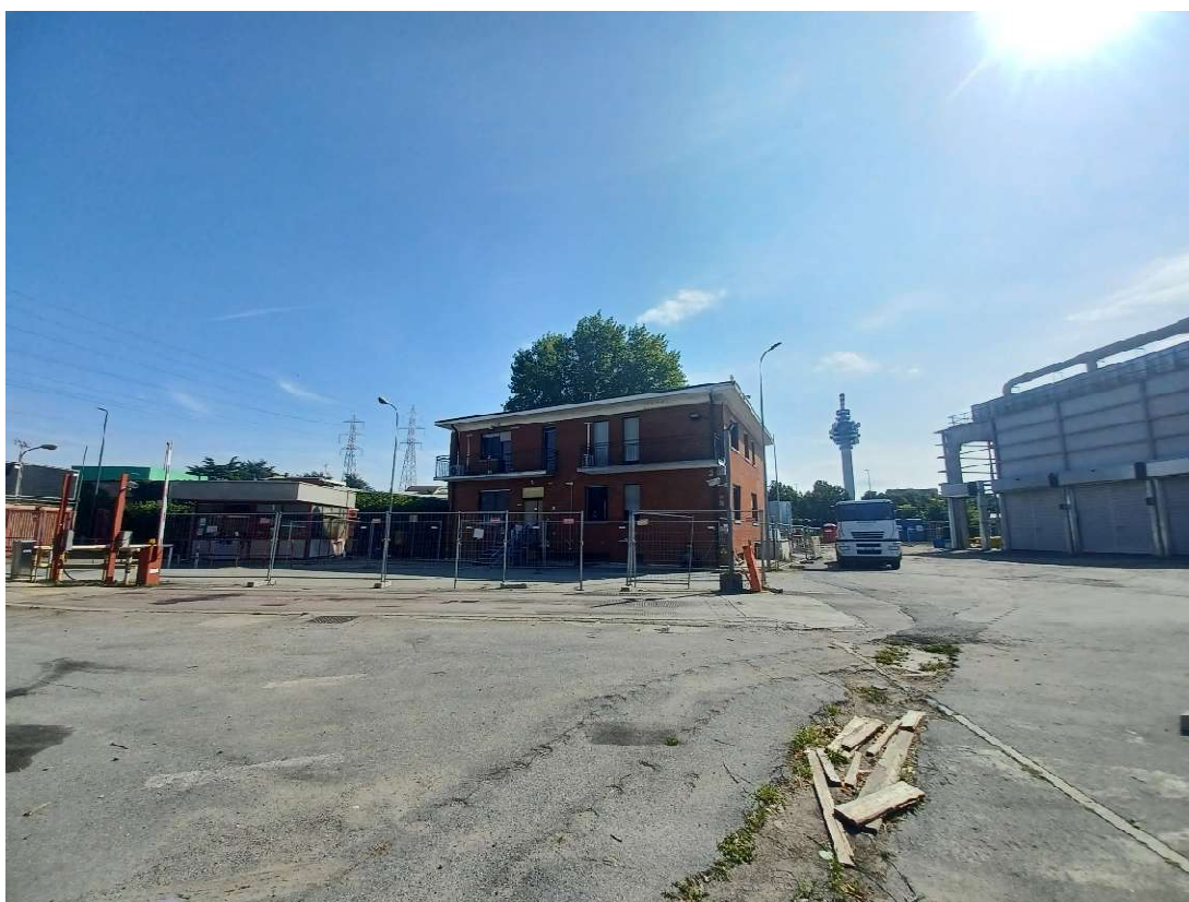
Fotografia 3 – Palazzina laboratori/uffici e guardiola – Data 23.07.2025
