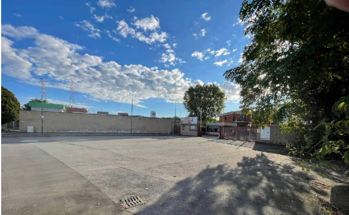
Figura 45: Il piazzale di ingresso da Via Manin
