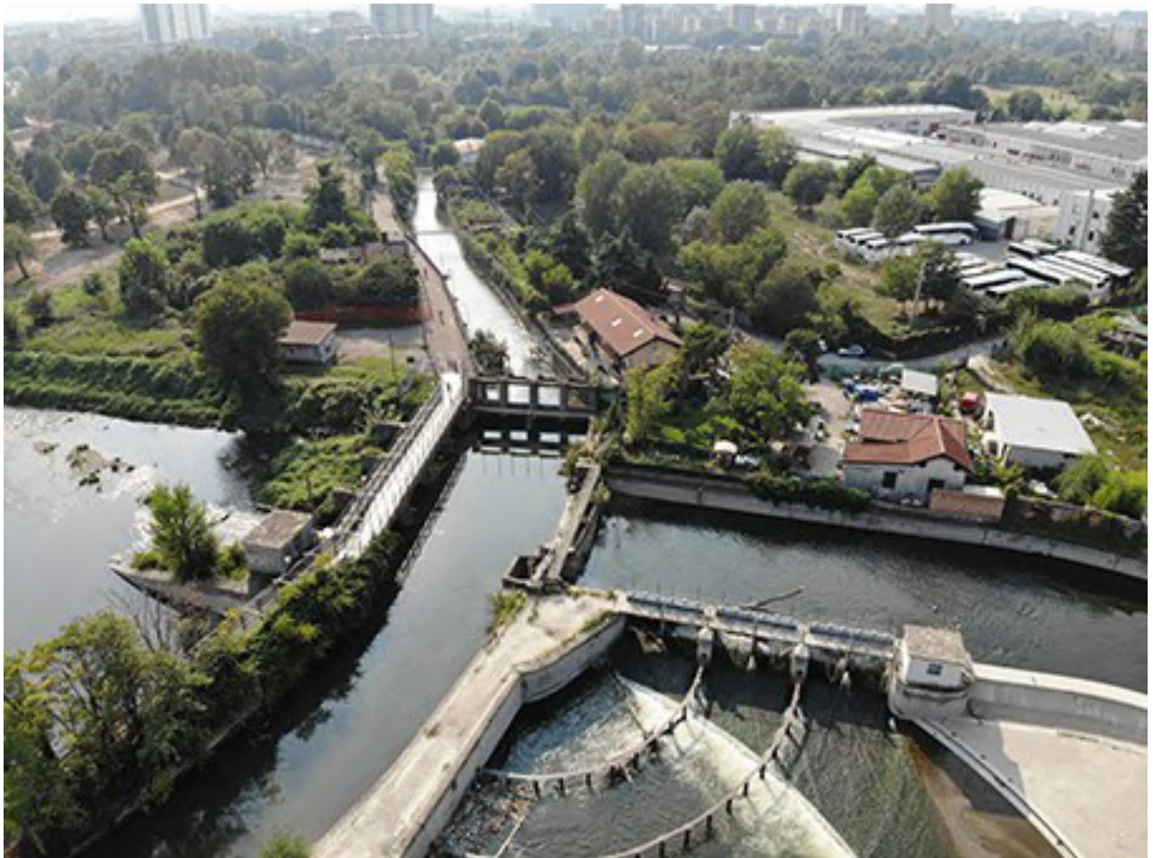
Figura 10: Il ponte canale del Naviglio Martesana ed il sifone del Lambro vista da Est
