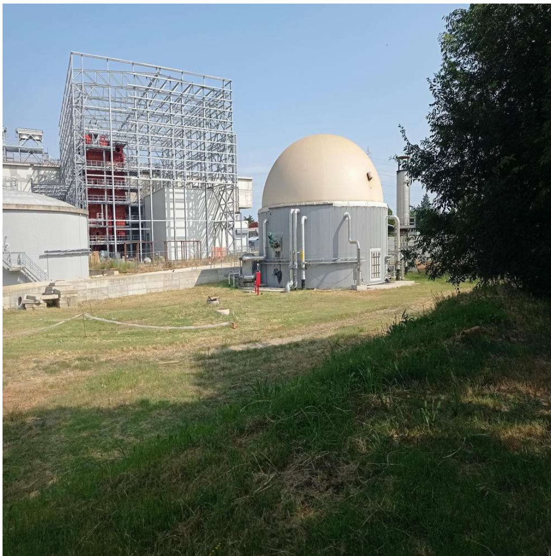
Fotografia 18 – Raffinazione biogas e pretrattamento FORSU – Data 26.05.2025
