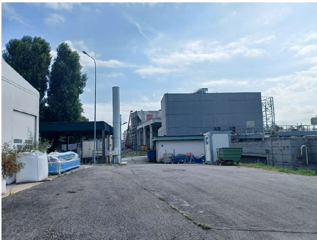
Fotografia 14 – CAP Impianto di depurazione – Data 23.07.2025
