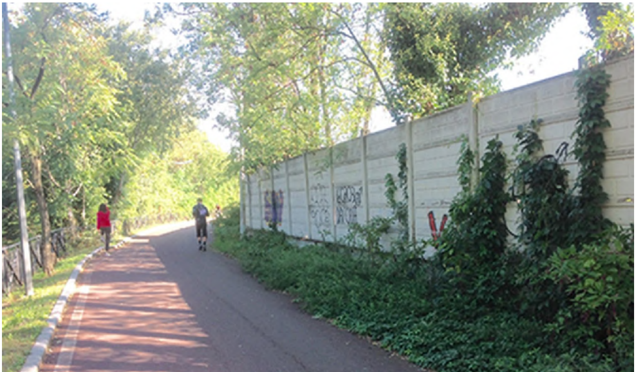
Figura 12: Il muro in cemento di recinzione lungo il Naviglio impedisce la vista dell'area boscata (data: 2021)
