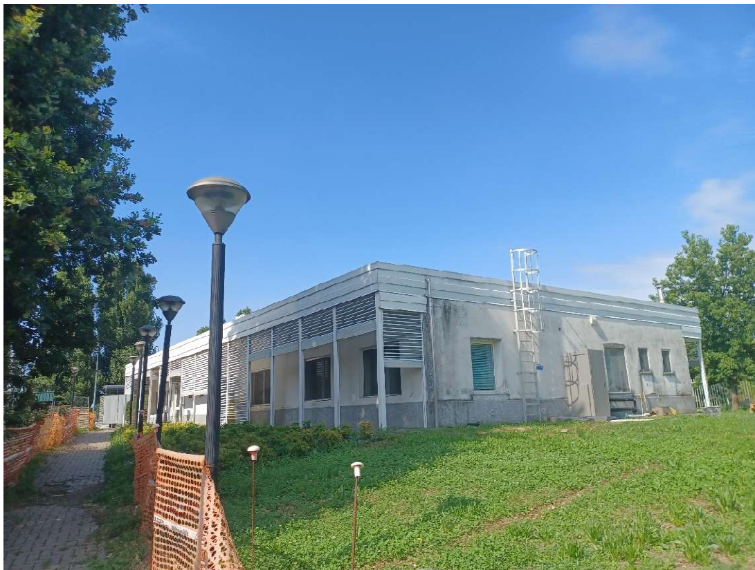
Fotografia 10 – Fronte Nord Ovest uffici – Data 23.07.2025
