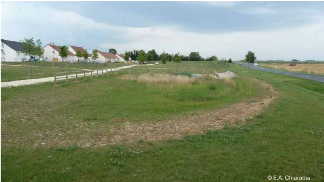
Figura 19: bacino di infiltrazione a valle di un complesso residenziale (Francia, foto E.A. Chiaradia)
