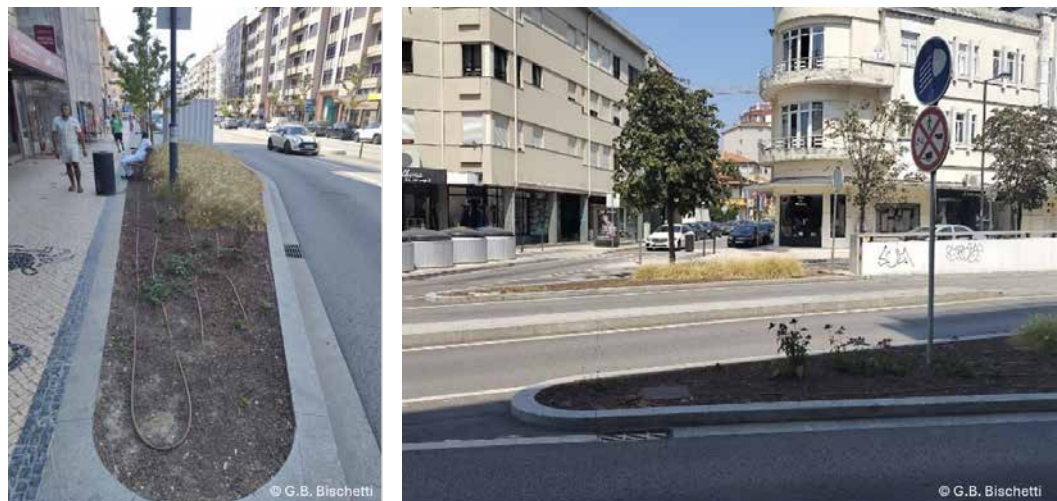
Figura 24: aiuole di bioritenzione, Aveiro, Portogallo (foto G.B. Bischetti)
