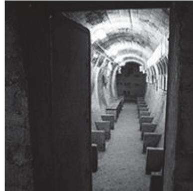
I rifugi sono delle gallerie lunghe e strette costruite in cemento armato, ognuna isolata dalle altre grazie alla chiusura di speciali porte blindate, anch'esse di uguale materiale, e sufficientemente robuste da resistere ai danni provocati da un'esplosione a breve distanza.
