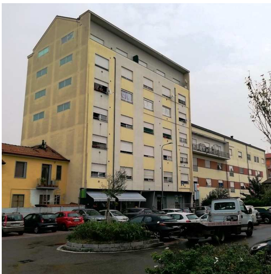
FOTO 1 – FACCIATA OGGETTO DI INTERVENTO
