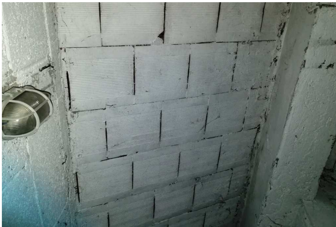
FOTO 9 – soffitto inclinato nella zona di ingresso al piano sottotetto
