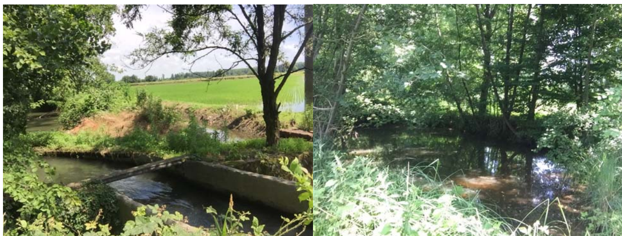
Foto dell'incastro idraulico e del Fontanile Fontaniletto.
