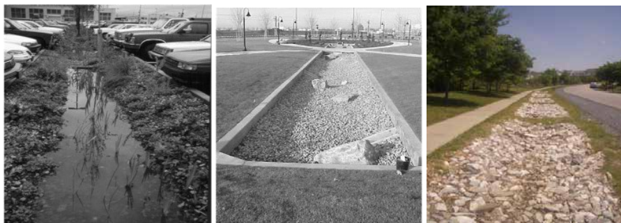
Figura 28 – Esempi di trincee d’infiltrazione
