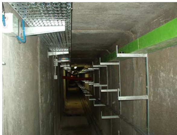
Cunicolo tecnologico in fase di approntamento
