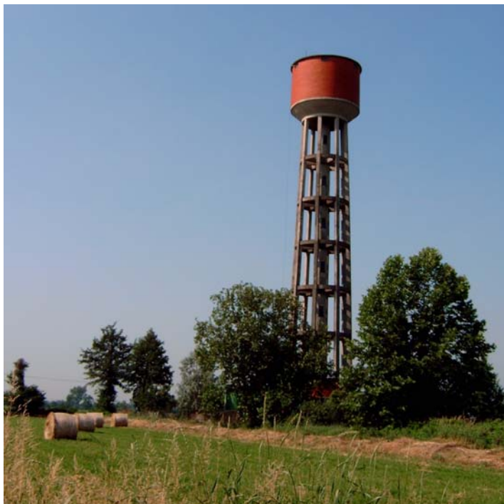
Esempio di torre piezometrica
