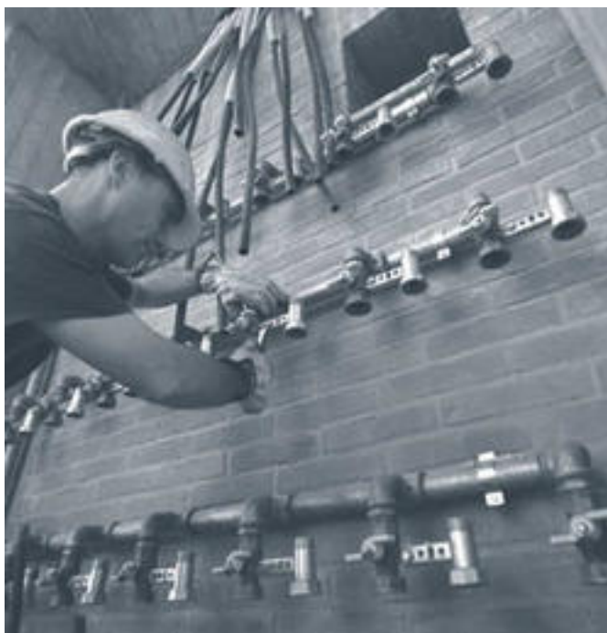
Rubinetti gas predisposti per allaccio contatori.
