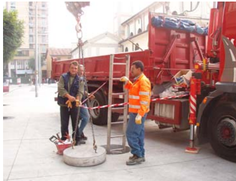
Ispezione di una galleria tecnologica
